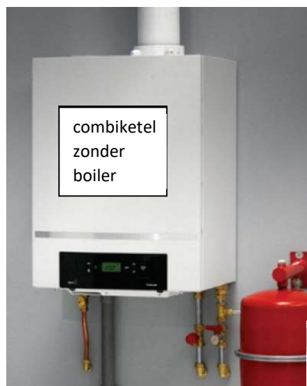
Combi-gaswandketel met ingebouwde compacte warmtewisselaar voor sanitair warm water (compacte maar minder comfort)
